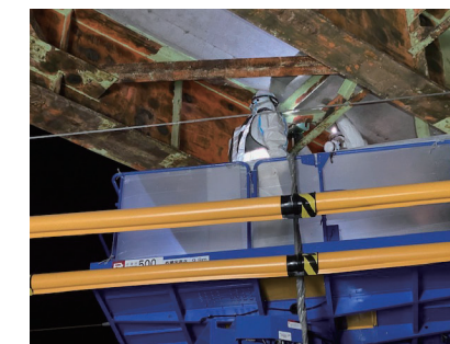
軌陸作業車での施工
