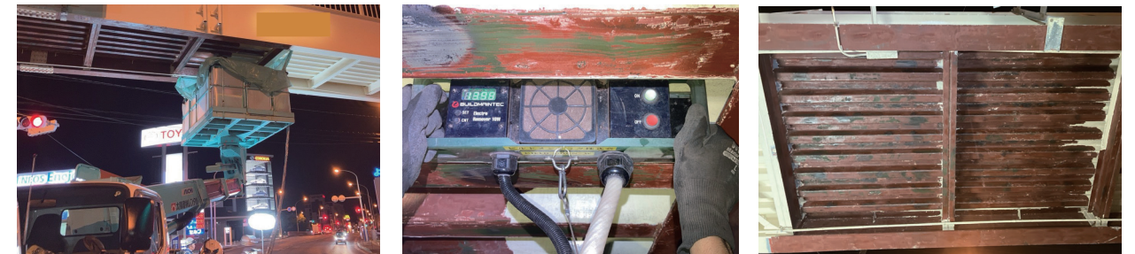
歩道橋高所作業車での施工
